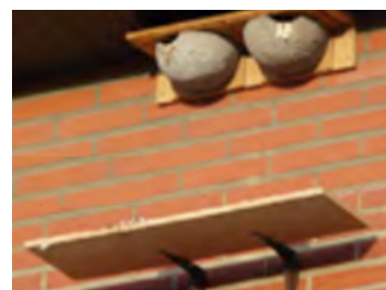
Planches antifientes à installer à environ 50 cm sous les nids.
