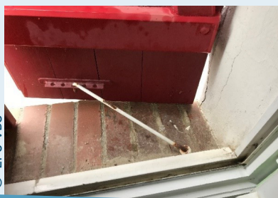
Volet entrebâillé permettant le passage des hirondelles et la pénombre.
