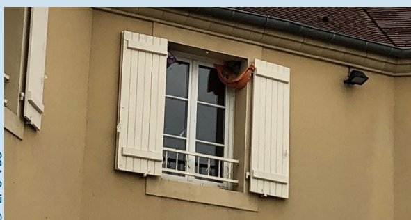
Tissu accroché au-dessus d'une fenêtre et sur le gond d'un volet formant un hamac qui recueille les déjections.
