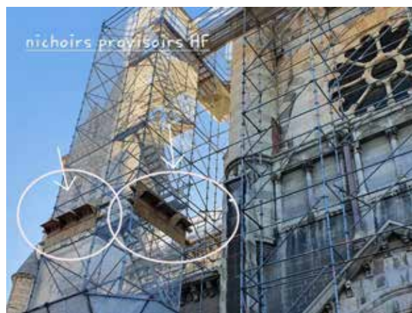
Nichoirs provisoires installés sur les échafaudages, Cathédrale St Arnoux, Gap, 2022, ©Valérie Vincent
