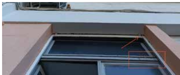
Coffrage de store occupé, bâtiment de l'Arsenal de Toulon, © Katherine DUBOURG
