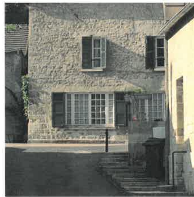
Large fenêtres horizontales
