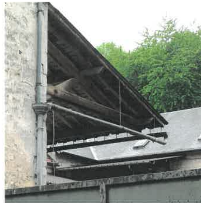
Débord de toits et mise en scène du chemin de l'eau
