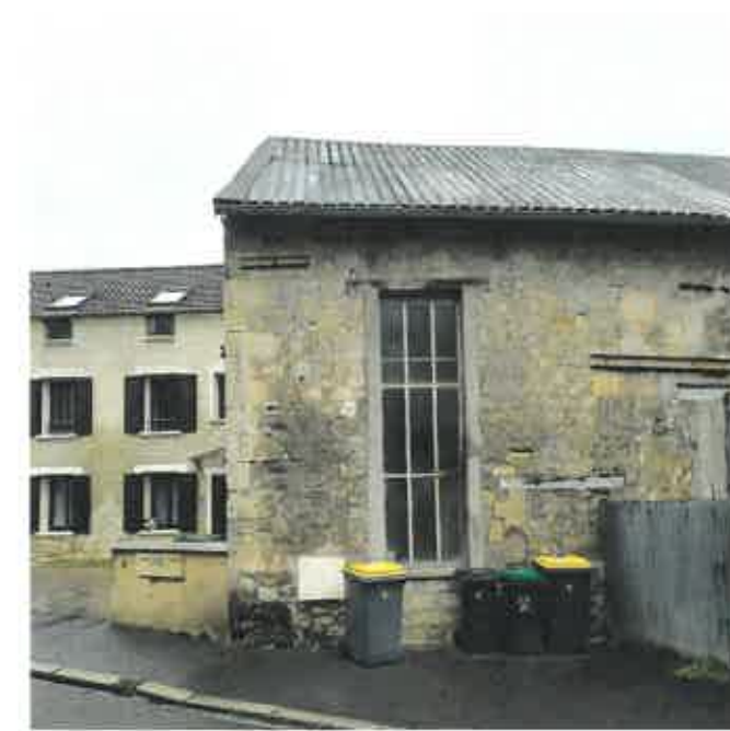
Tôle métallique de couverture et ouverture verticale
