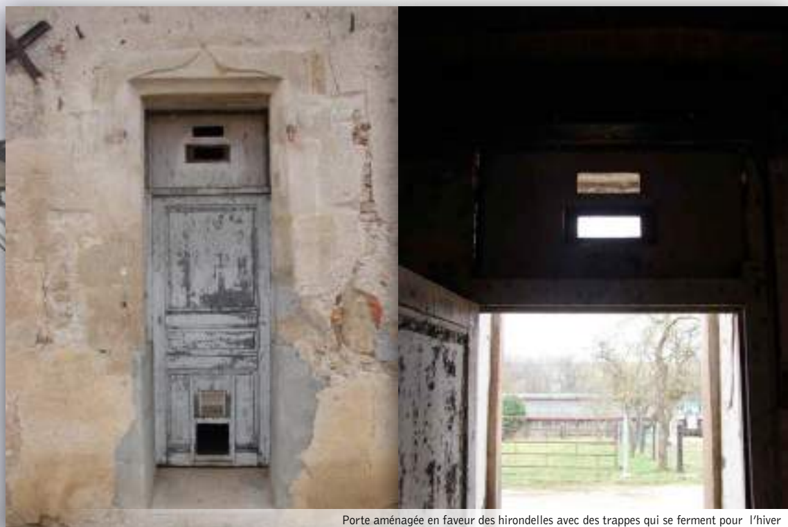
Porte aménagée en faveur des hirondelles avec des trappes qui se ferment pour l'hiver
