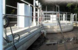
Le traitement biologique est le cœur de l'installation, il consiste à faire dégrader, par des micro organismes naturellement présents dans l'eau, les matières organiques (azote, carbone, phosphore) qui y sont dissoutes. Ces bactéries utilisant l'oxygène comme énergie, une injection d'air est effectuée dans certaines parties du bassin. Cette étape conduit à la formation de boues biologiques.
