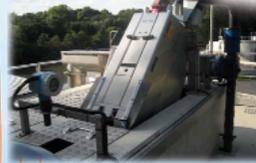
Le dégrilleur automatique et la grille manuelle sont dimensionnés pour accepter le débit maximum de pointe du traitement biologique soit 100 m<sup>3</sup>/h.
