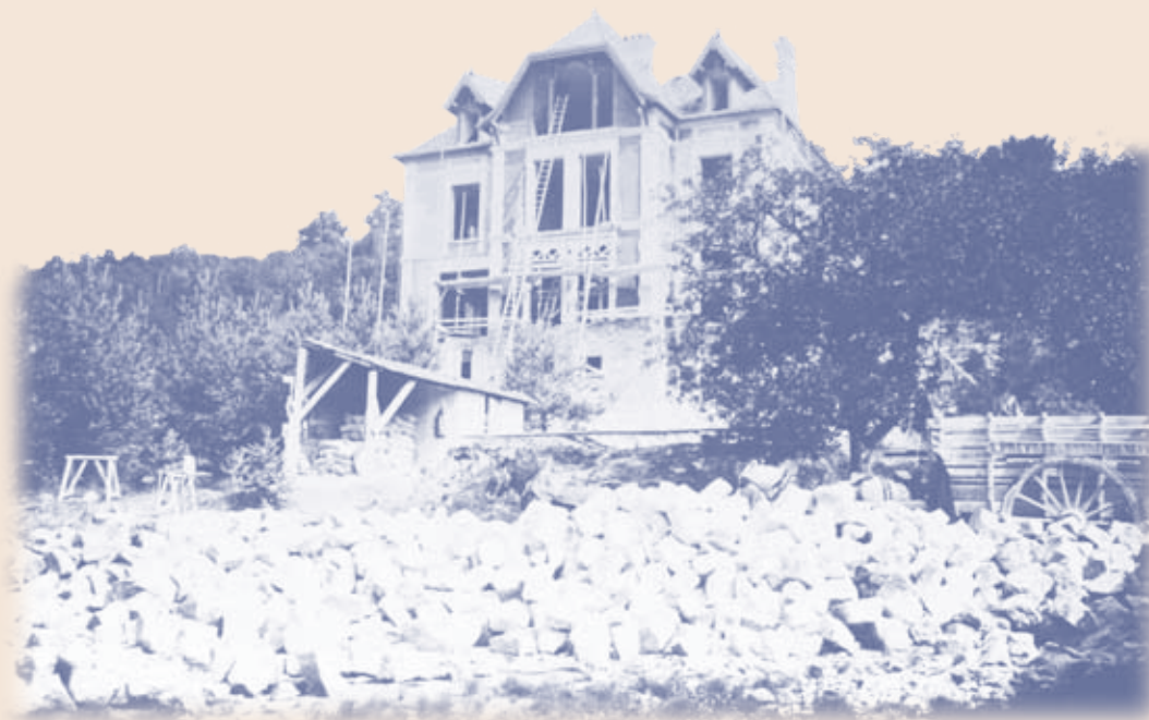
La maison Bescherelle en construction © Carte postale (Coll. Privée)
